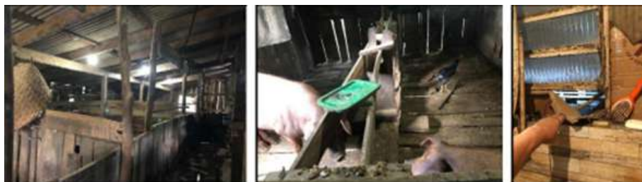
Figura - Alojamento em que o trabalhador residia, situado próximo ao chiqueiro, e banheiro ao lado, sem ventilação adequada Fonte: relatório 2023.303.MTE.RS.
