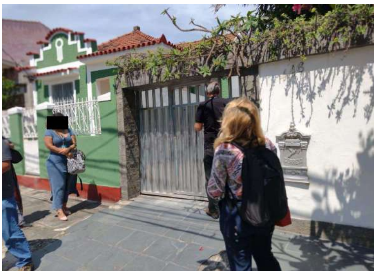
Figura - Fachada da casa onde houve a fiscalização 2021.263.MTE.RJ 119 Fonte: relatório 2021.263.MTE.RJ.
