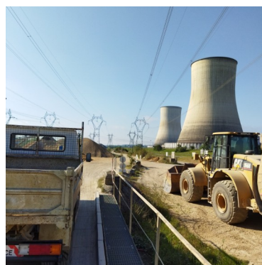
Depuis mai 2022 les 2 réacteurs de Civaux sont arrêtés suite à des fissures détectées sur les circuit RIS Réseau d'injection de secours.
