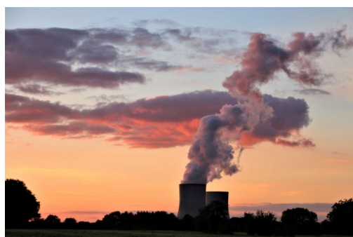
Civaux Sécheresse 2021, plus qu'un seul réacteur en fonctionnement. Panache de vapeur sur fond de coucher de soleil . 4 août 2021 Photo 3 J luc Herpin
