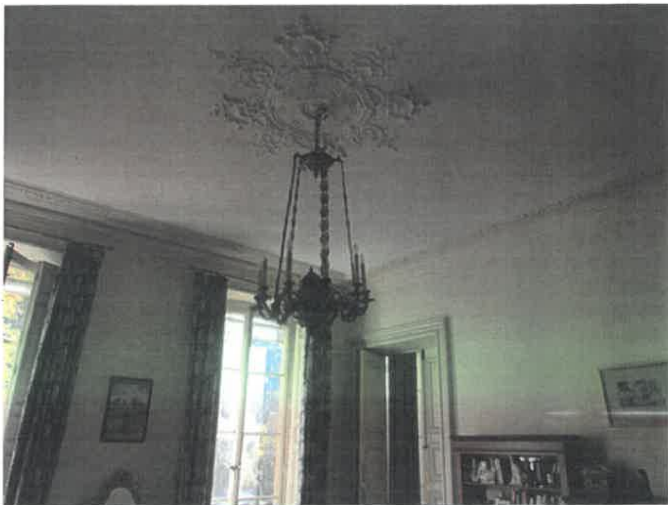
Photo de la chambre principale avant travaux :
